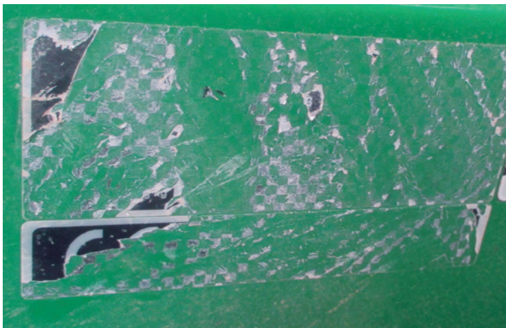
Ausencia de placa de identificación a causa del deterioro
